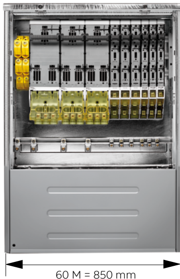
Moduldimensionerat skensystem i kabelskåpet.
